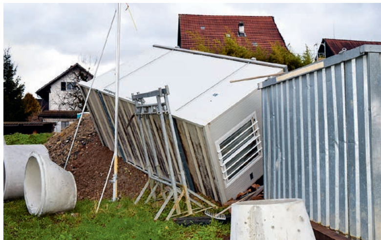
Die Gewalt des Sturms lässt sich u.a. an diesem umgekippten Baucontainer erkennen. Bild: Christoph Lehmann
