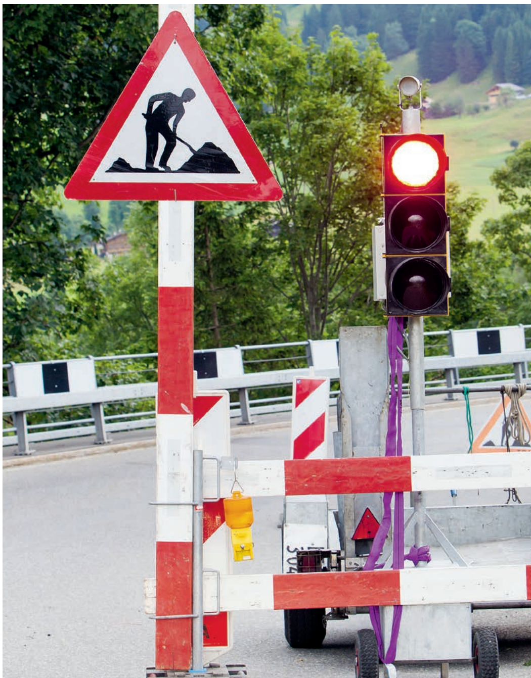
An der Ampel heisst es erst mal warten. Die zahlreichen Baustellen sind für viele Verkehrsteilnehmer ein Ärgernis.
