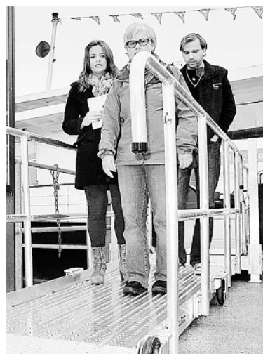
Der neue Steg in einer leichten Aluminiumbauweise.
