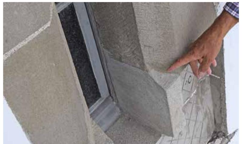
Derzeit präsentiert sich der Kirchturm eingerüstet. Ein näherer Blick zeigt Schäden am Verputz (rechts oben) und sogar abgetrennte Betonzielelemente (rechts Mitte). Manche Risse sind bereits ausgebessert (rechts unten), viele Steine sind aber noch im Atelier des Steinmetzes in Bearbeitung. Bilder: Christoph Lehmann
