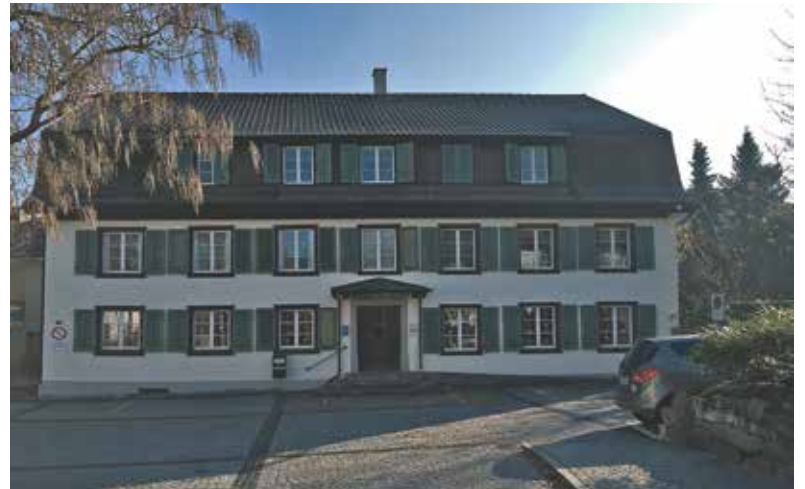
In diesem Gebäude im Zentrum von Maur, wo sich auch die Bibliothek befindet, ist der Schulpsychologische Dienst aktuell untergebracht. Bild: Annette Schär
