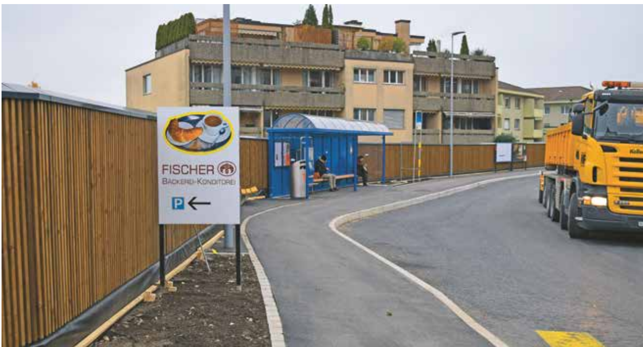
Neue Haltestelle und Lärmschutzwände bei der Bushaltestelle «Dorf».
