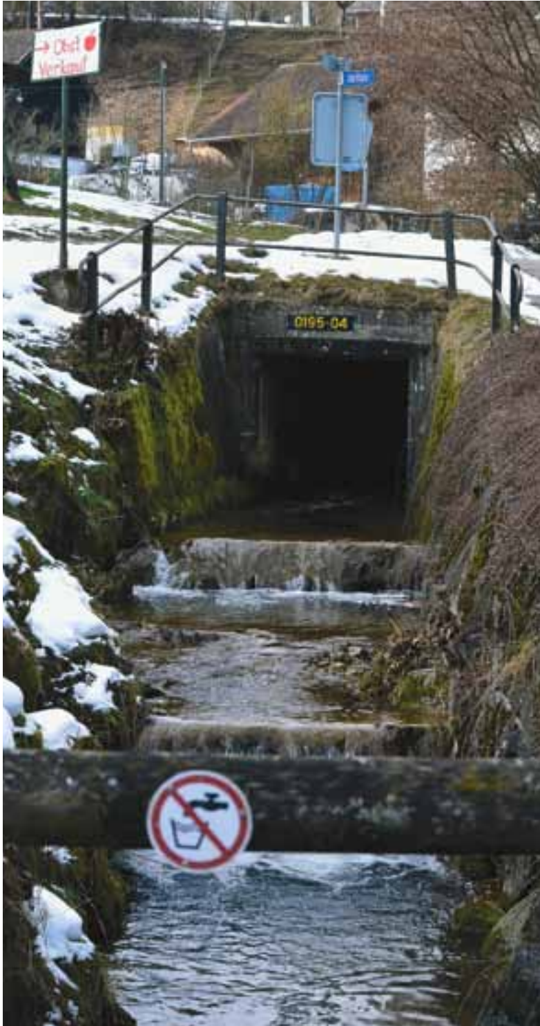
Mit Anpassungen am Uessiker Dorfbach soll das Siedlungsgebiet bei Hochwasser besser geschützt werden.
