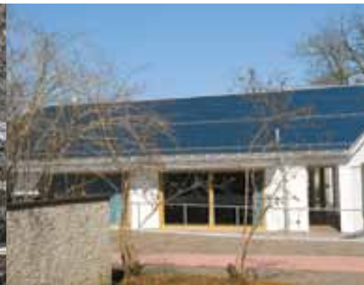
Bietet sich beim Dach des KGH Kreuzbühl auch eine Möglichkeit für die Energiegewinnung an?
