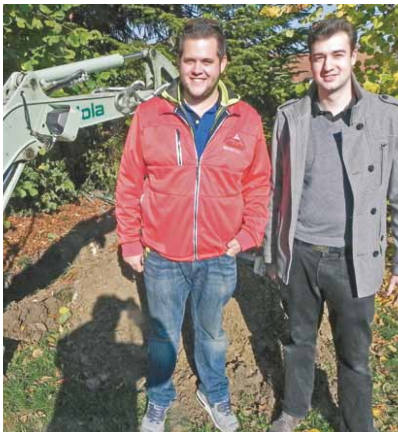
Simon Loser und Oliver Brunner von der GGA-Bauleitung vor einem Aushub eines Kabeldurchzuglochs.
