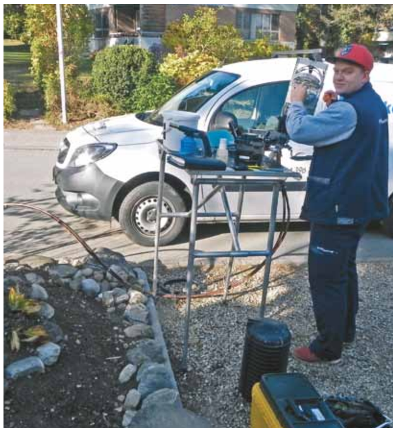
Fachmann verspleisst das Koaxialkabel mit dem neuen Glasfaserkabel in einem der rund 100 Maurmer Verteilkästen der GGA.
