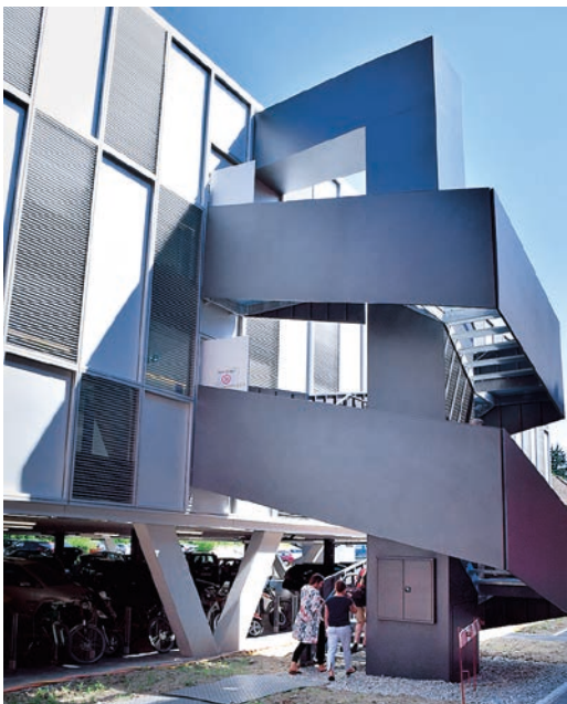
Der Neubau auf Stützen.
