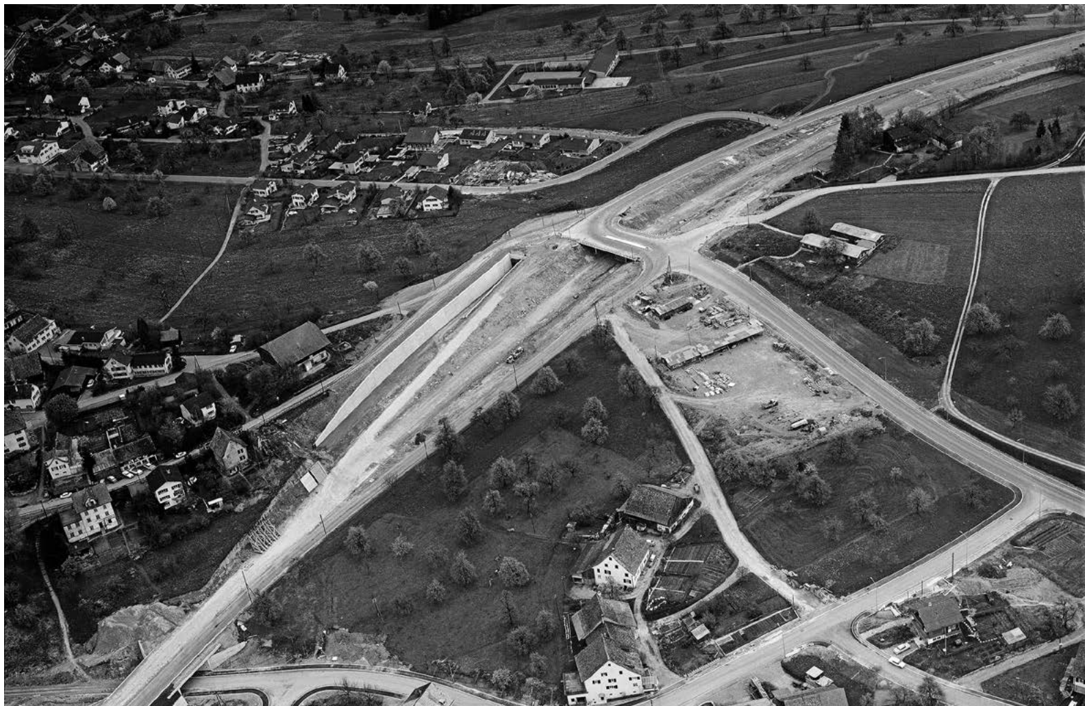
Das Luftbild von 1963 zeigt die Forchstrasse im Bau. Schon erstellt ist die Brücke, erkennbar auch die neue Führung der Forchbahn. Im Hintergrund das noch wenig bebaute Quartier Maiacher mit dem Schulhaus Aesch. Bild: ETH-Bibliothek Zürich, Bildarchiv
