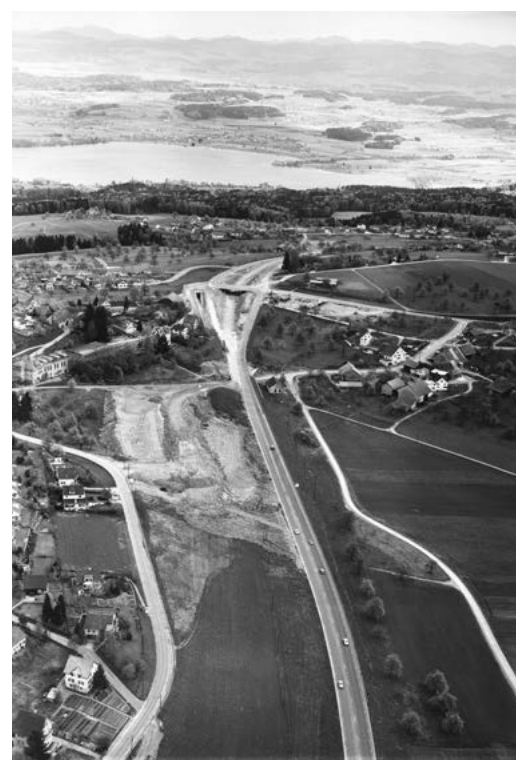
Imposant: die neue, frisch erstellte Autostrasse. Links das alte Forchbahndepot, rechts Kaltenstein. In der Bildmitte sieht man die Brücke mit dem neuen Forchbahntunnel und im Hintergrund den Greifensee. Bild: ETH-Bibliothek Zürich, Bildarchiv
