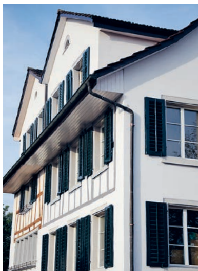
Entdeckung: Die Fachwerkfassade war früher verdeckt.
