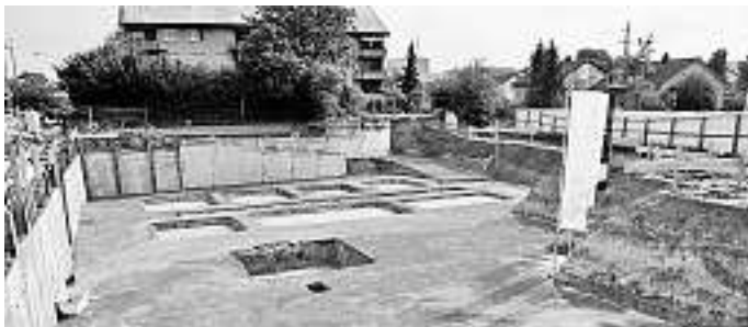
Die Baugrube mit dem kleinen Loch für die Schatulle der Grundsteinlegung.
