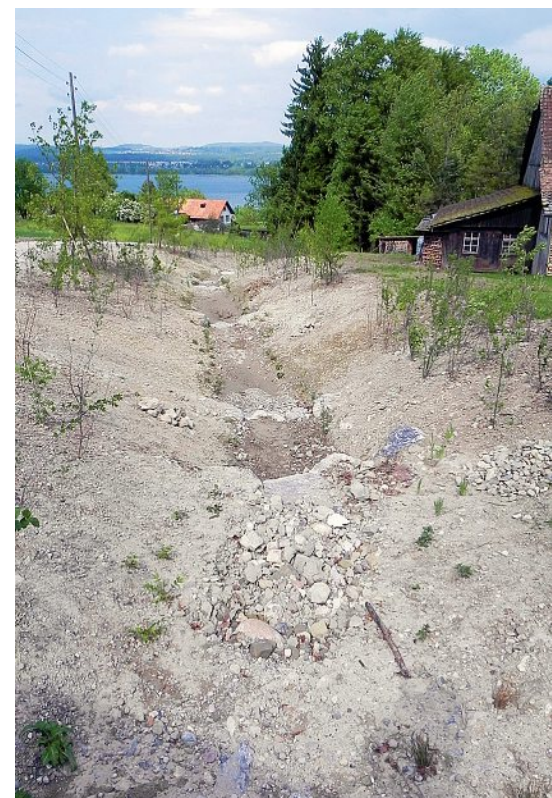
Auf einer Länge von fast 100 Meter entstand ein neues Bachbett.
