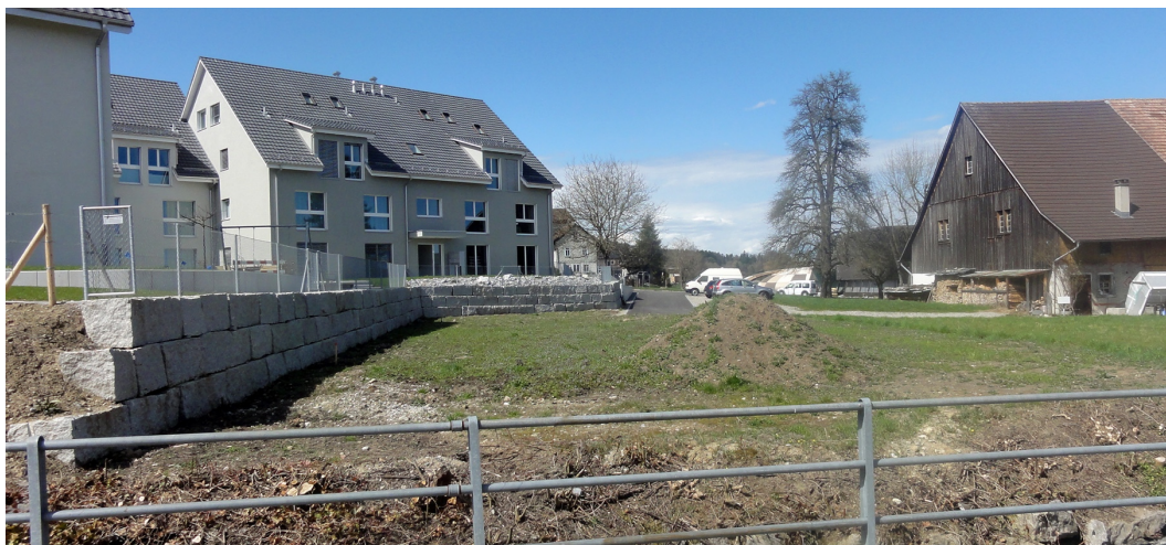
Abb. 22 Foto Teilgebiet C / Baubereich C2 (rechts), Blick in Richtung Kehlhof (Foto: asa AG)
