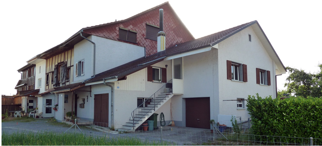
Abb. 12 Inventarisierte Reihenhäuser Kehlhofstrasse 4-12 (A37), von der Kehlhofstrasse her
