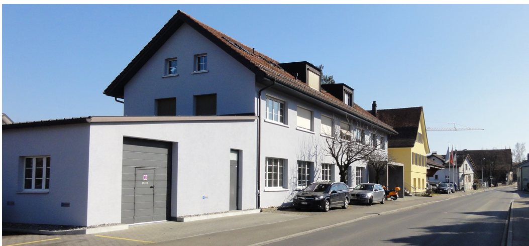
Abb. 15 Inventarisiertes Gebäude Fällandenstrasse 6 (A38), von der Fällandenstrasse her
