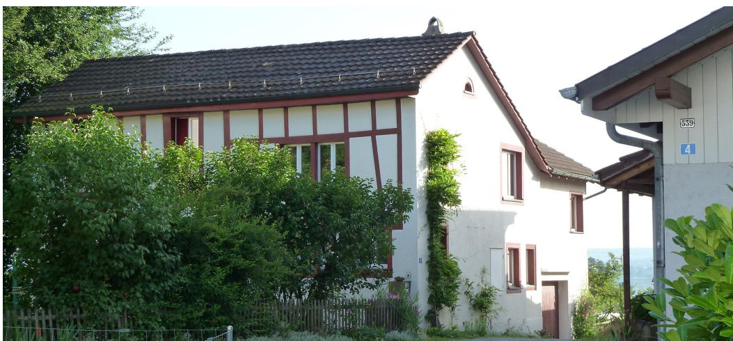
Abb. 10 Inventarisiertes Gebäude Kehlhofstr. 20 (A30), von der Kehlhofstrasse her
