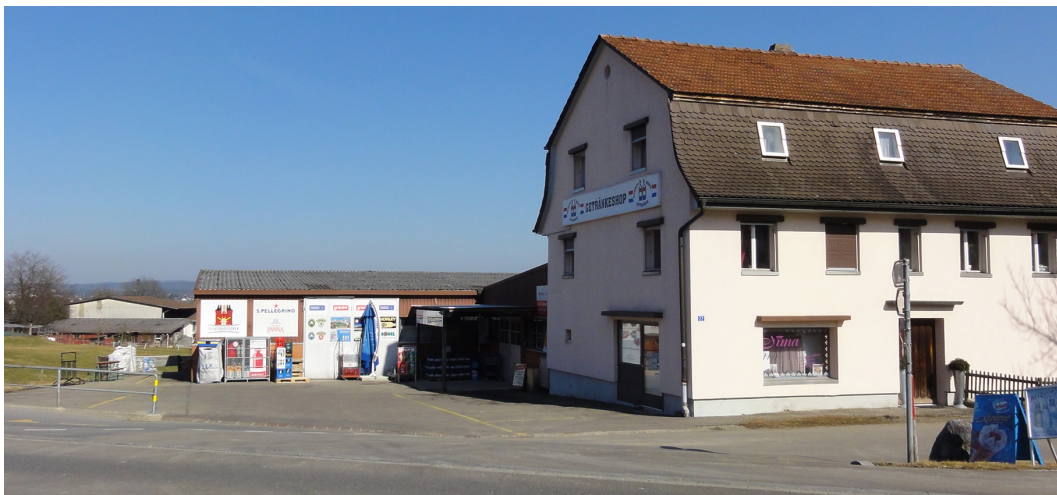
Abb. 29 Foto Teilgebiet F, Blick aus Richtung Fällandenstrasse (Foto: asa AG)
