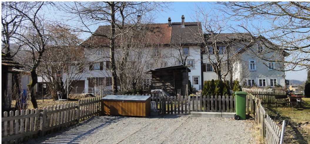
Abb. 13 Inventarisierte Reihenhäuser Kehlhofstrasse 4-12 (A37), von der Badanstaltstrasse her
