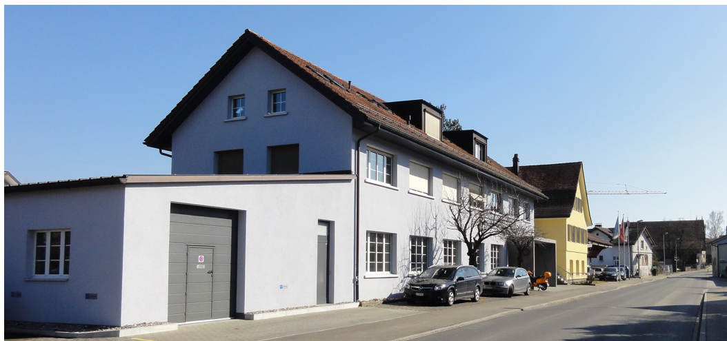
Abb. 31 Foto Teilgebiet G, Blick aus Richtung Fällandenstrasse (Foto: asa AG)
