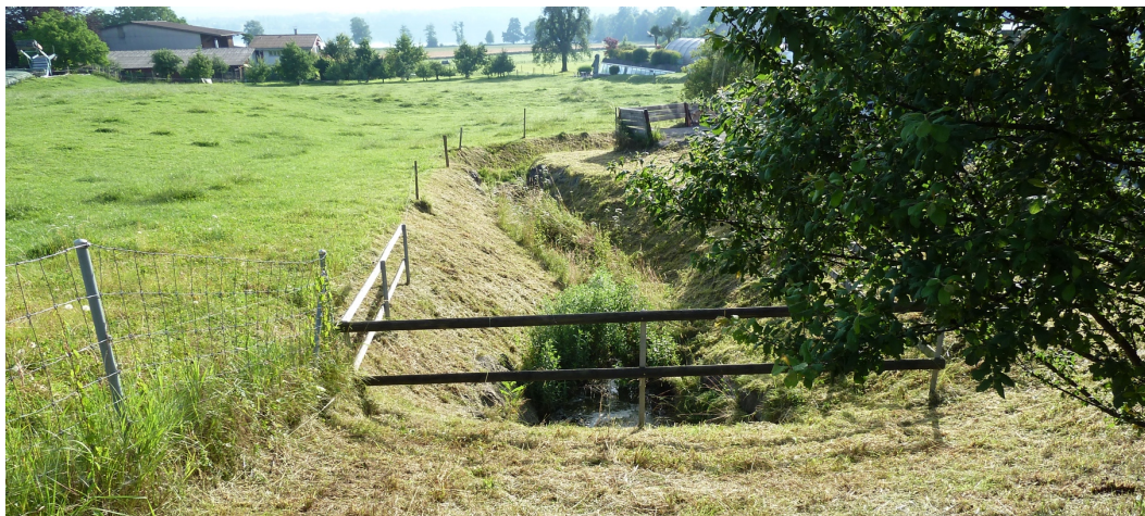
Abb. 7 Offen geführter Dattenbach innerhalb Gestaltungsplanperimeter (Foto: asa AG)
