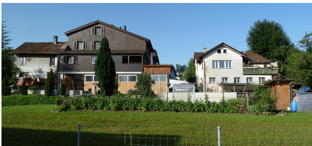
Abb. 14 Inventarisierte Gebäude, links Kehlhofstr. 4-12 (A37), rechts Kehlhofstr. 20 (A30), vom See her
