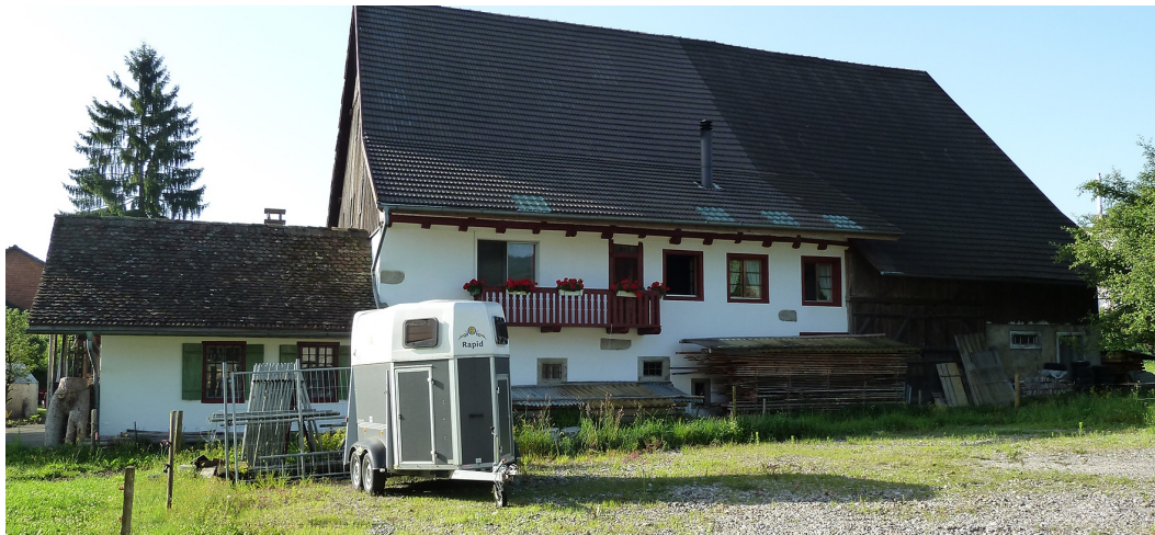
Abb. 16 Inventarisiertes Gebäude Unterdorf 38 (A42), von der Badanstaltstrasse her
