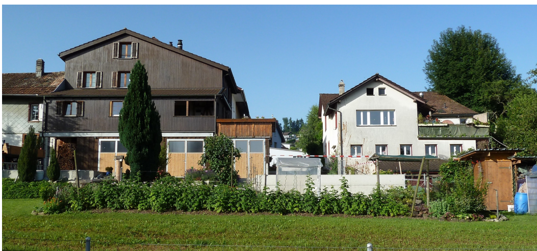
Abb. 11 links Inventarobjekt (A37), rechts Inventarisiertes Gebäude Kehlhofstr. 20 (A30) vom See her
