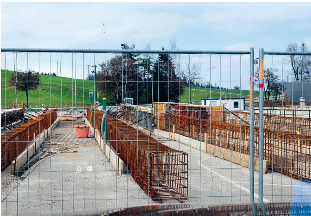
Bevor die Bauzäune hochgezogen werden, müssen beim Bauamt die erforderlichen Bewilligungen eingeholt werden. Kritiker bemängeln die komplizierten Abläufe.
