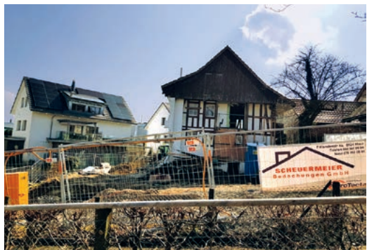
Die derzeitige Baustelle.
