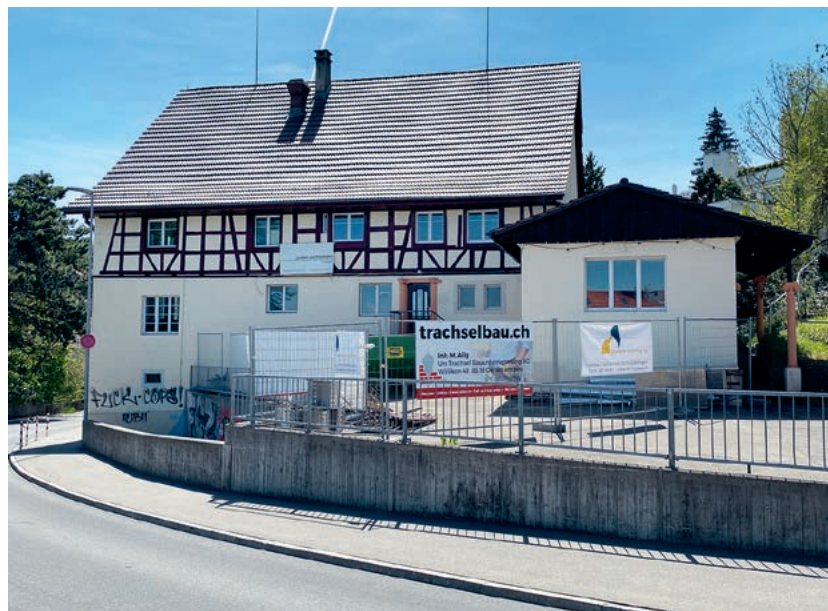
Seit einigen Wochen umgeben Bauzäune die historische Liegenschaft in der scharfen Kurve in Ebmatingen. Mitte des 19. Jahrhunderts befand sich im «Wilden Mann» die Poststelle Ebmatingen, auch Gemeindeversammlungen wurden dort abgehalten.
