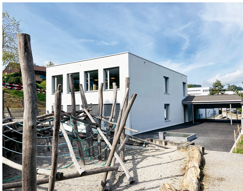
In Rekordzeit umgesetzt: der neue Anbau beim Schulhaus Aesch. Bild: Annette Schär
