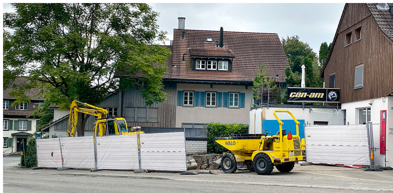
Seit einigen Tagen sind die Bagger am Werk bei der Zürichstrasse. Bild: Dörte Welti
