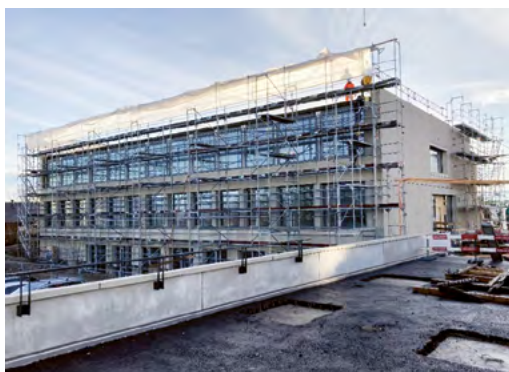
Schulhaus Ost: auf dem Foto noch eingerüstet, aber schon bald saniert.
