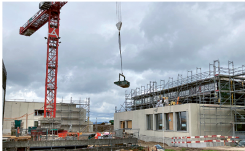
Mehrkosten bei der Loorenbaustelle.
