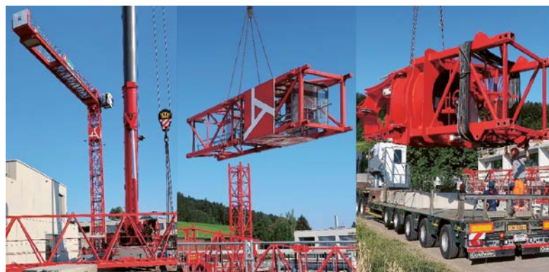
Der Turmkran auf der Looren wurde Anfang Juli demontiert.
