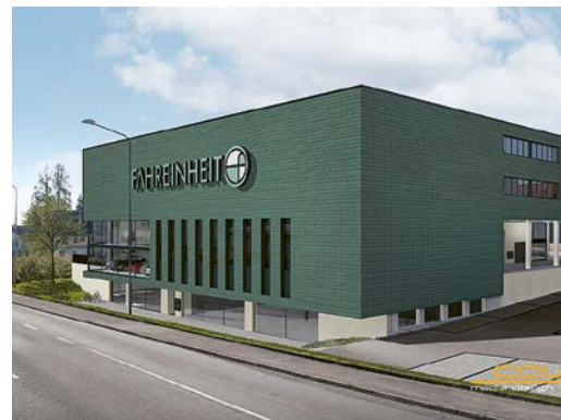
Noch im Bau: das neue Kompetenzzentrum für Classic Cars in Grüningen. Bild: zVg
