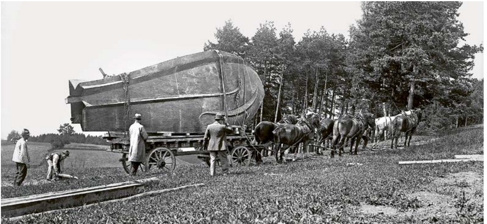
Transport mit sechs Pferden: Das Bodenstück der Flamme bei der Ankunft auf dem Bauplatz.
