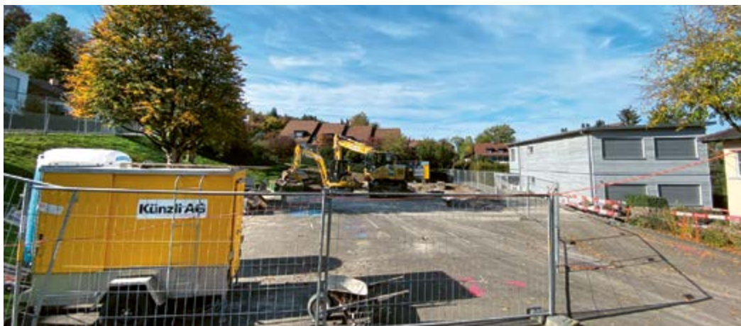
Beim Schulhaus Pünt sind die Bagger vorgefahren, der Bau des Provisoriums hat begonnen.
