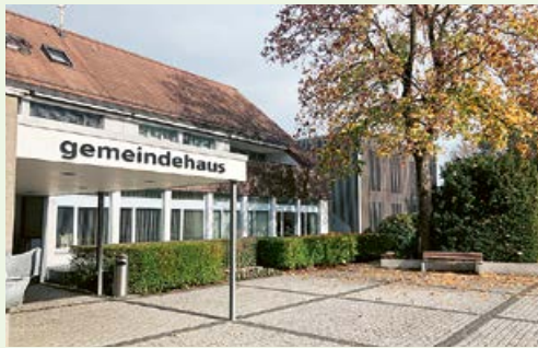
Gemeindeforum Maur: Der Erweiterungsbau mit Holzelementen (rechts im Bild) soll nur ein «Provisorium» sein. Bild: Annette Schär
