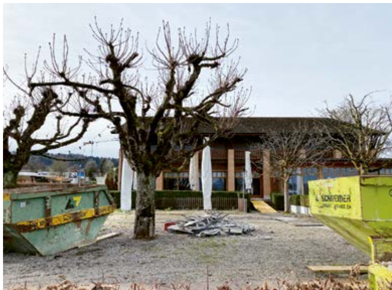
Bauzäune und Mulden vor der Schiffflände.
