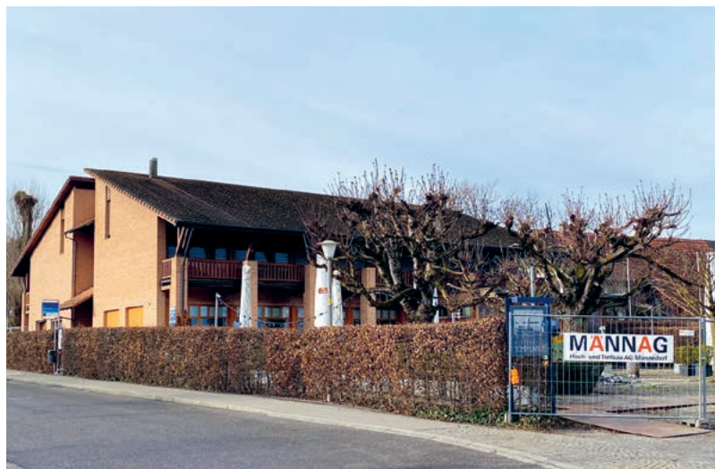
Die «Schifflande» soll bis im Herbst fertig umgebaut sein.
