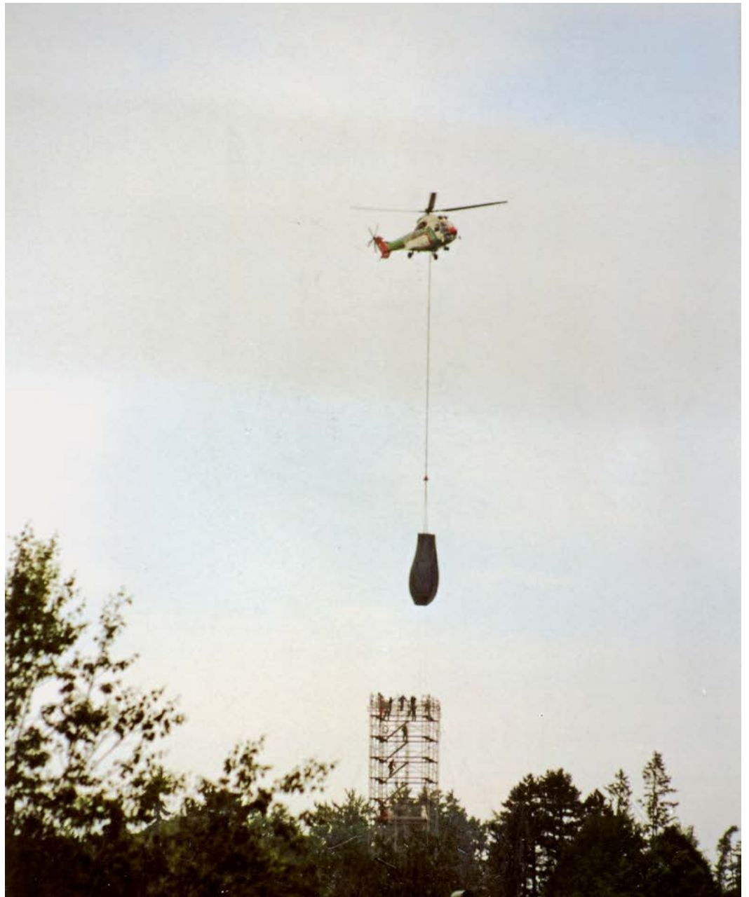
Der fliegende Baukran mit dem bauchigen Bodenstück.
