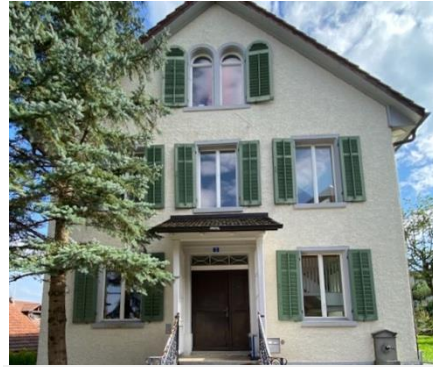
Alter Kindergarten Prüfung Sanierung
