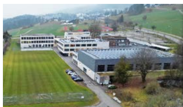
Der künftige Standort des neuen Bevölkerungsschutzgebäudes. (Foto: DHPA Architekten AG)
