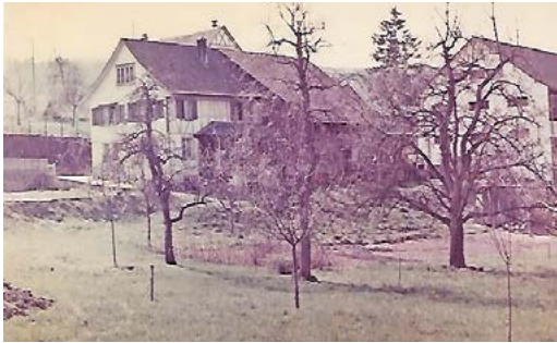
Eine ältere Aufnahme vom späteren Baugelände mit dem Neuhof (links), der bis 1962 dort gestanden hatte, bevor er abbrannte.
