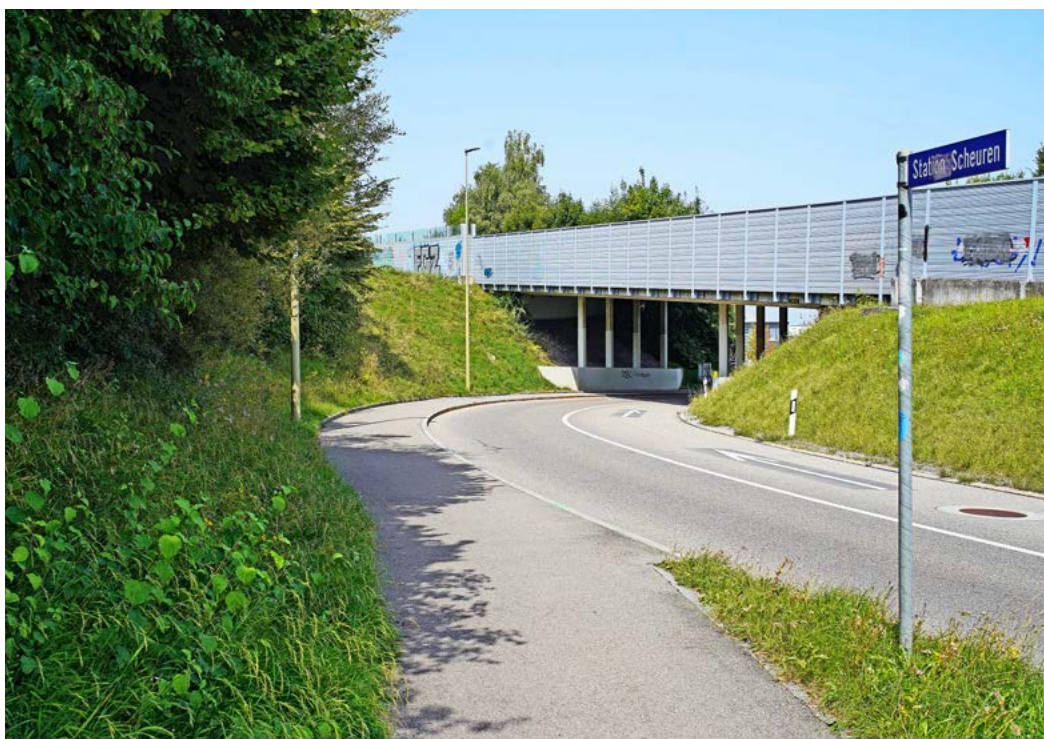
Der Fussweg zwischen dem Kreisel in Aesch und dem Bahnhof Scheuren wird ab dem 22. September 2025 für rund zwei Wochen durch einen Verkehrsdienst geregelt. Bild: Forchbahn
