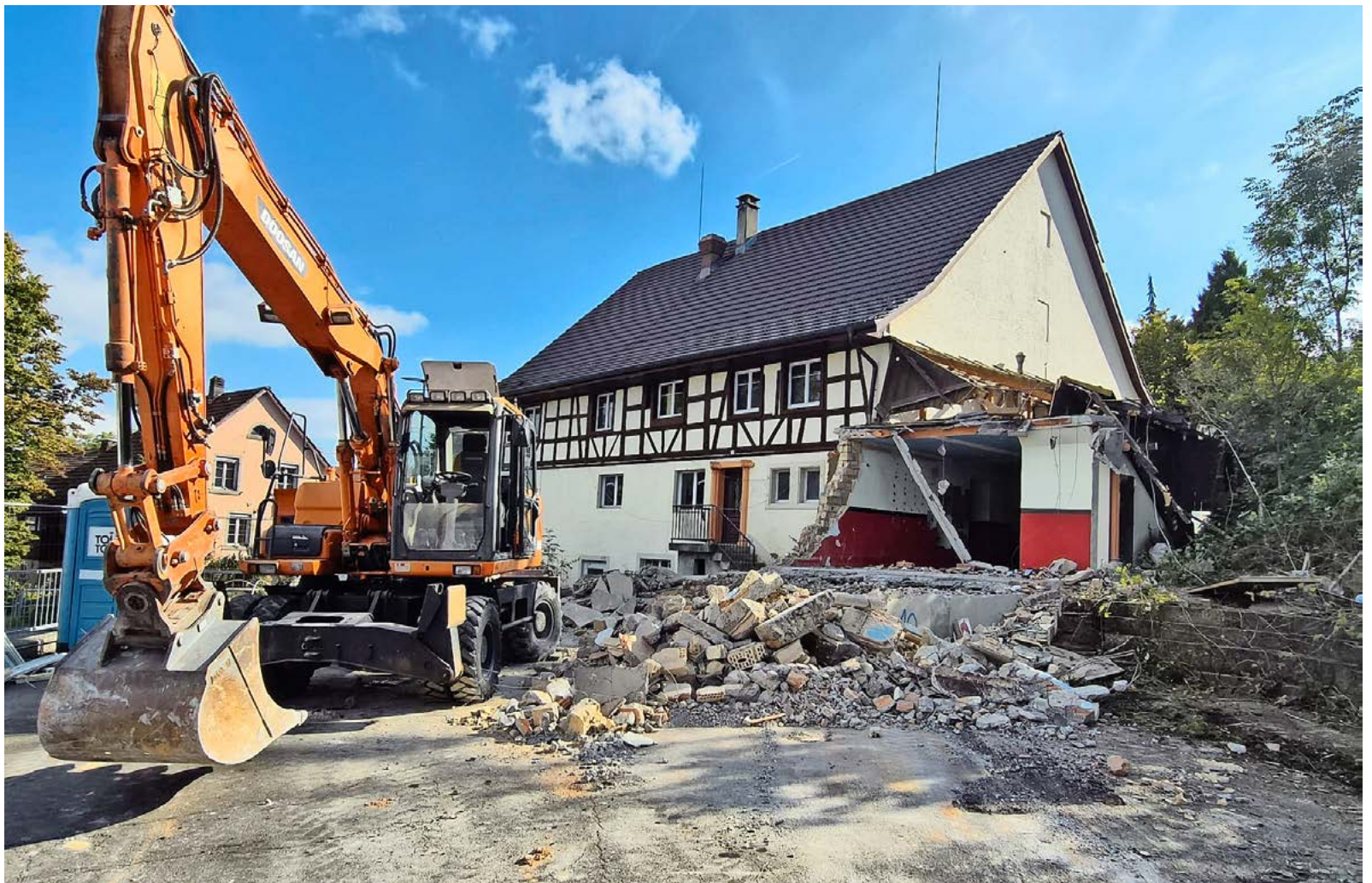
Am vergangenen Montag fuhr der Bagger beim «Zum Wilden Mann» auf und begann mit dem Abbruch des Anbaus.
