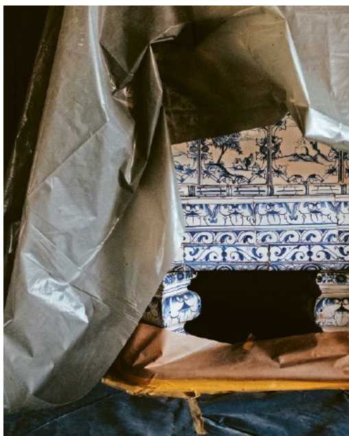
Historische Details wie der alte Ofen im Restaurant bleiben als Herzstück des denkmalgeschützten Baus erhalten.
