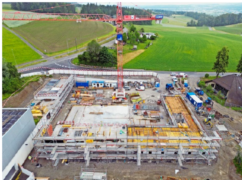
Mit dem Rohbau des Bevölkerungsschutzgebäudes geht es vorwärts.
