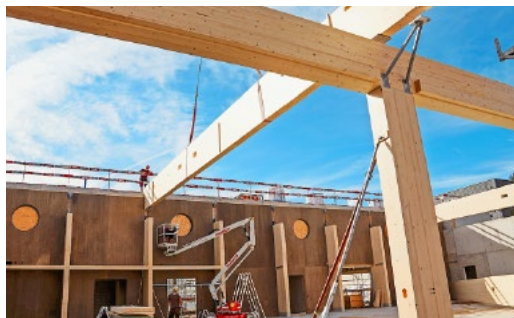
Langsam wird das Drei-Tonnen-Holzelement an seinen vorbereiteten Platz gebracht.
