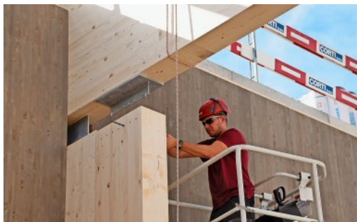
Hier muss der Arbeiter alle vorgebohrten Löcher noch einmal durchbohren, bevor das Holzelement endgültig herabgelassen wird und anschliessend riesige Schrauben eingedreht werden.
