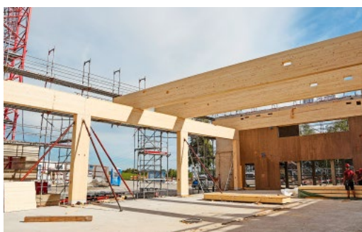
Und langsam nimmt die Halle Gestalt an.
