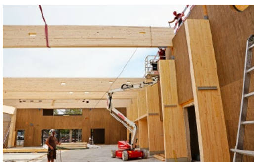
Auf der hinteren Wandseite werden die Elemente mit Metallprofilen, sogenannten Schwertern, ineinander verkeilt.
