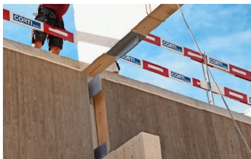
Der Montagearbeiter ist zuständig für das genaue Einpassen des Metallprofils in die Kerbe.
