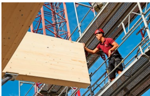
Auf der gegenüberliegenden Seite der Halle passiert gleichzeitig Ähnliches. Auch hier ist Handarbeit von einem Montagearbeiter gefragt, vom Gerüst aus schiebt er das Holzelement in die richtige Einkerbung, links im Bild.
